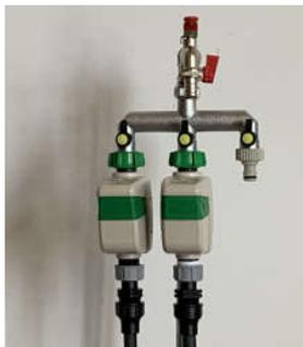
2) Bewässerungscomputer, die direkt auf einen Hahn oder Verteiler geschraubt sind, müssen vor Beginn der Frostperiode abmontiert werden, da sie NICHT frostfest sind!
